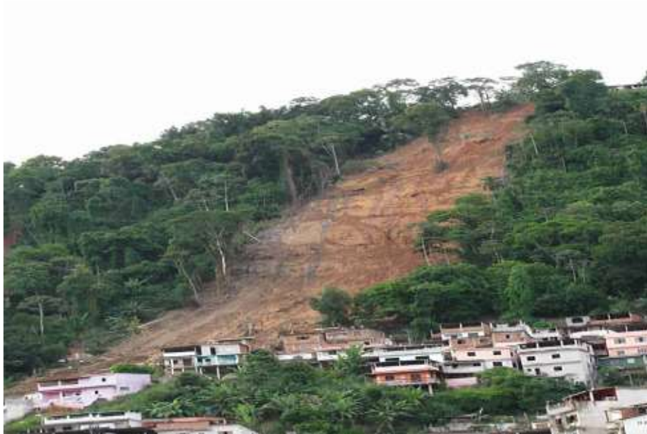
Figura 2 – Desmoronamento ocasionado pelas chuvas em Angra dos Reis/RJ
