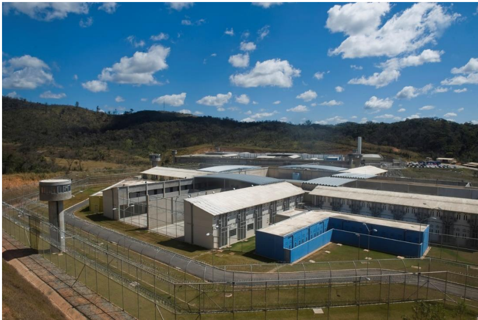
Infraestrutura do complexo penitenciário de Ribeirão das Neves
