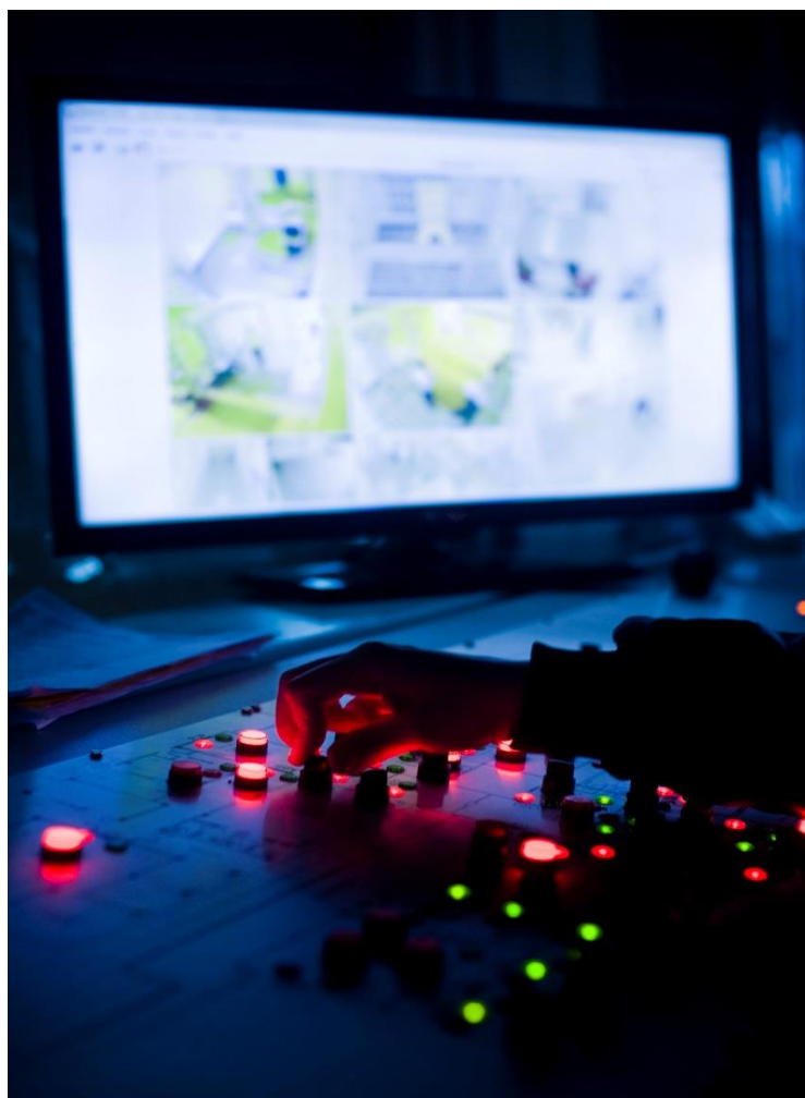
Central de monitoramento de câmeras e portões
